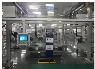
BMS程序刷写
