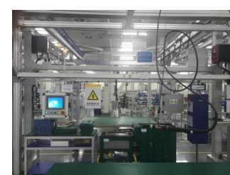
跨接铜排及电极 保护盖安装
